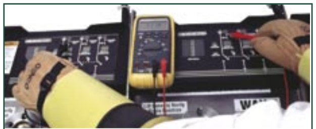
Figura 7. Midiendo el voltaje fase a fase ( Fase 1 a Fase 1).
