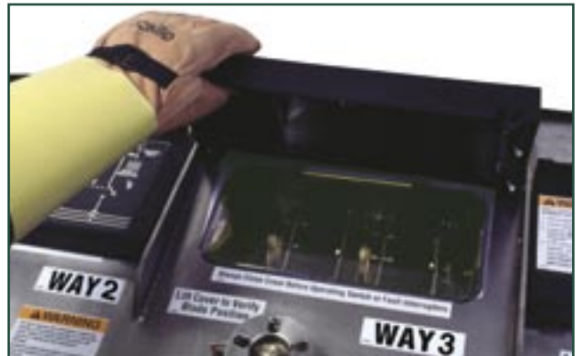
Figura 2. Cubiertas móviles en las mirillas para observar la posición de las cuchillas de seccionamiento del seccionador interruptor de carga o el interruptor de falla.
