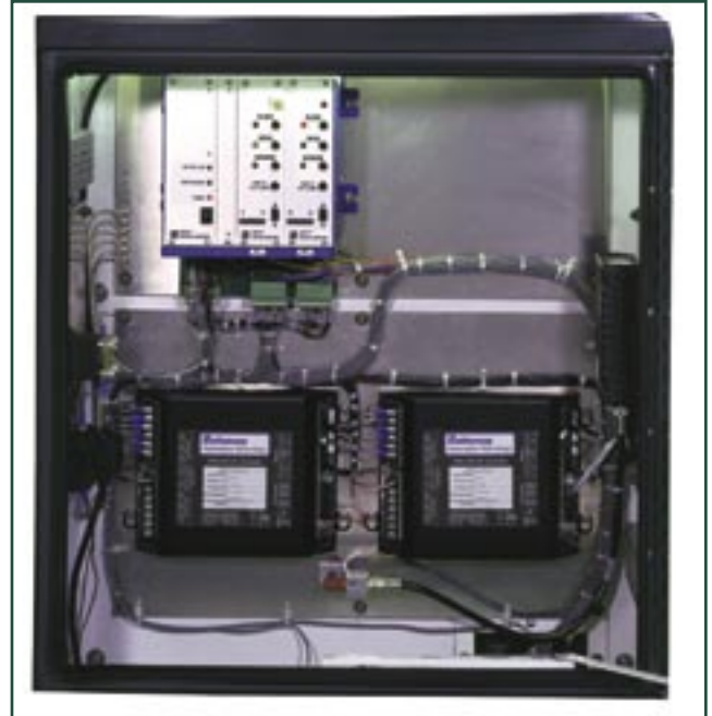
Detalles del compartimiento del Vista con Control Remoto Supervisorio Modelo 422.
